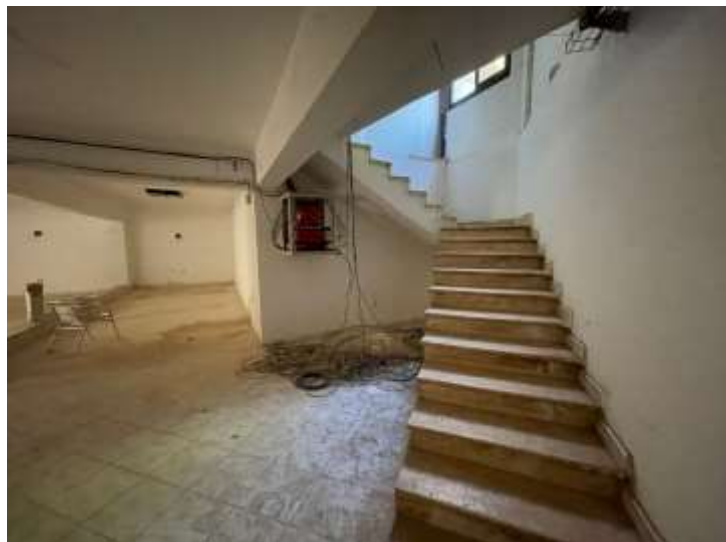
Fig. 1 - Vano scala lato Sud
