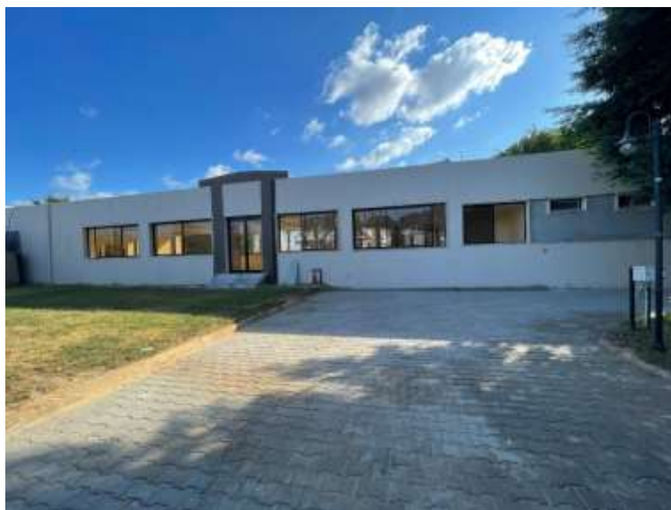
Fig. 9 - Parete esterna lato Ovest
