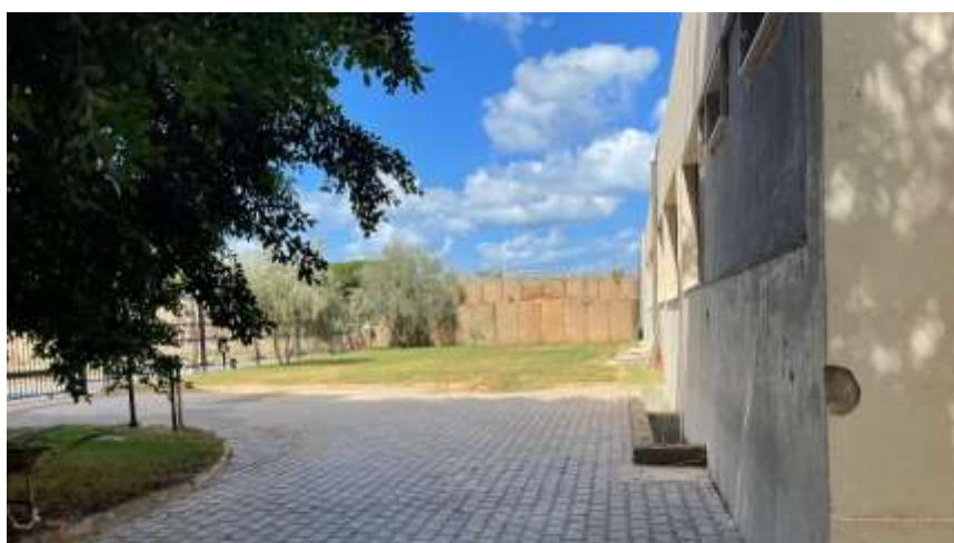
Fig. 2 – Ingresso lato ovest
