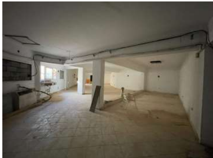
Fig. 2 - Ambiente interno lato Sud-Ovest
