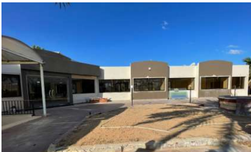
Fig. 2 – Ingresso lato est corte esterna
