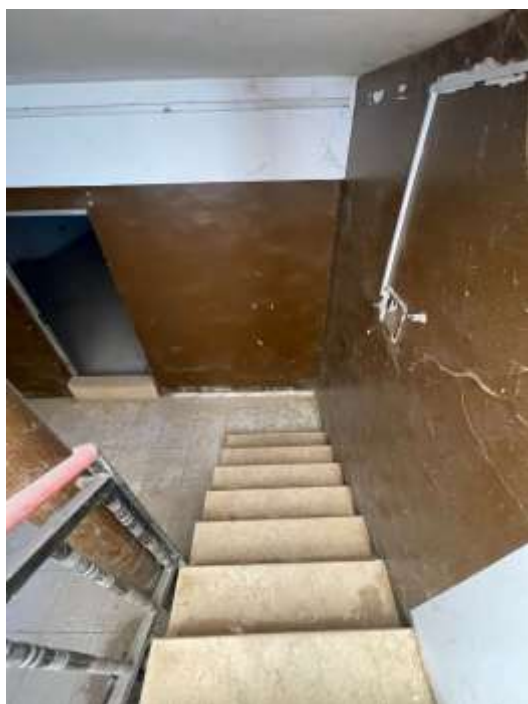
Fig. 5 - Vano scala lato Nord
