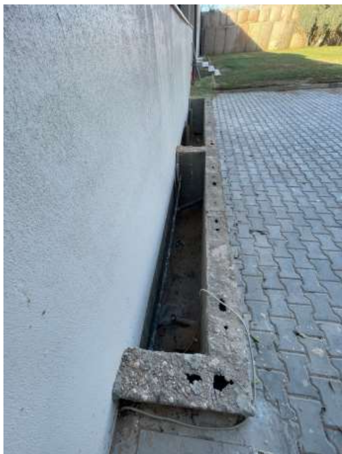
Fig. 11 - Finestra in trincea murata
