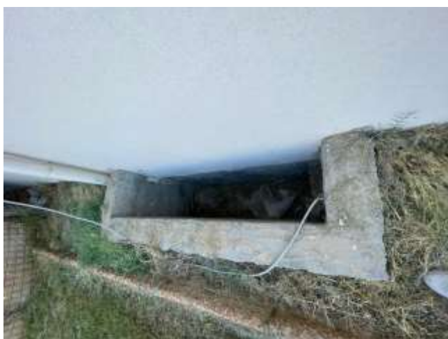
Fig. 10 - Finestra in trincea murata
