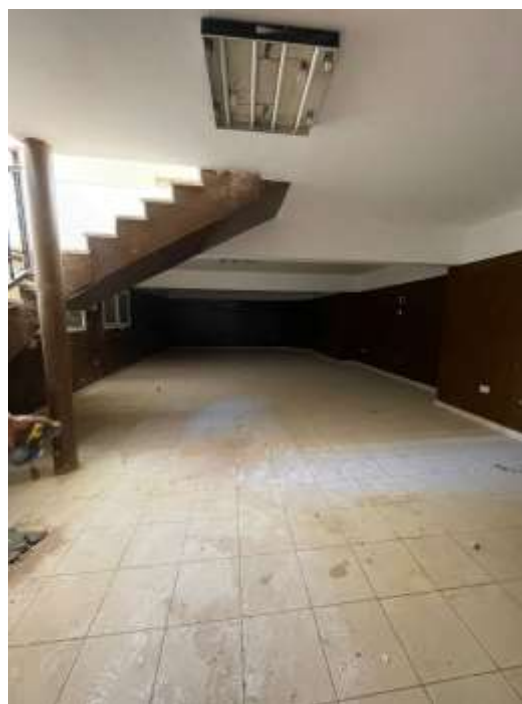
Fig. 6 - Ambiente interno lato Nord
