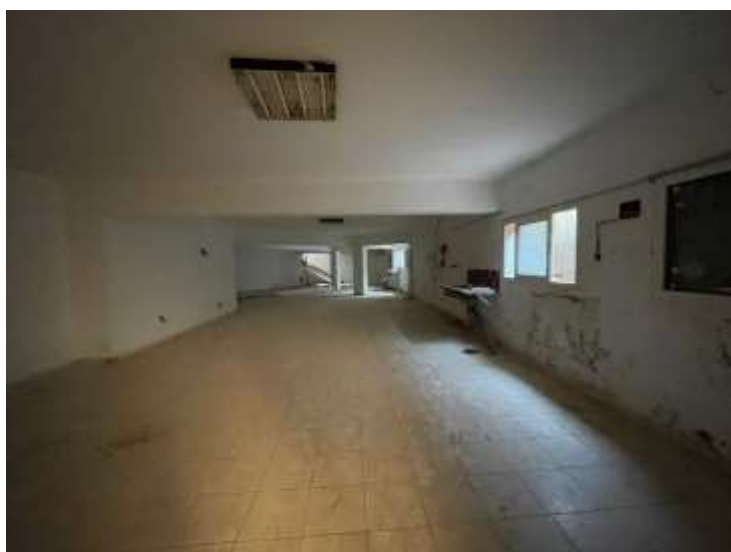
Fig. 3 - Ambiente interno lato Ovest
