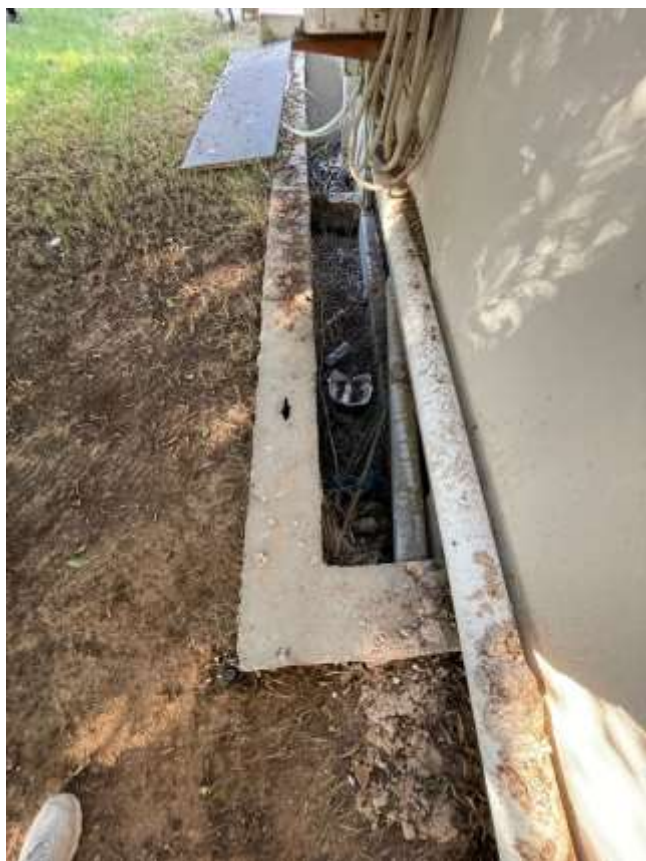
Fig. 8 - Trincea alloggiamento finestre piano interrato
