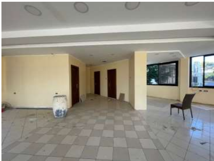
Fig. 7 - Area servizi igienici e vano scala
