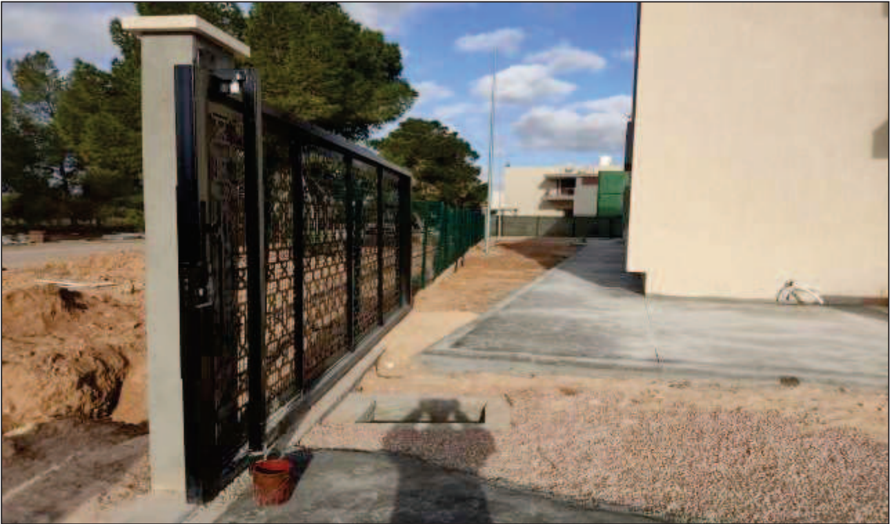
Immagine 5 – Ingresso carrabile lato Sud Est
