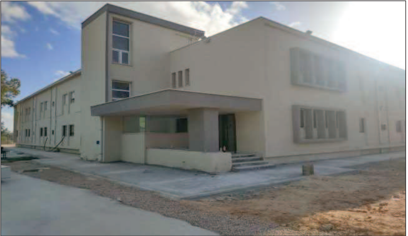
Immagine 1 – ingresso principale
