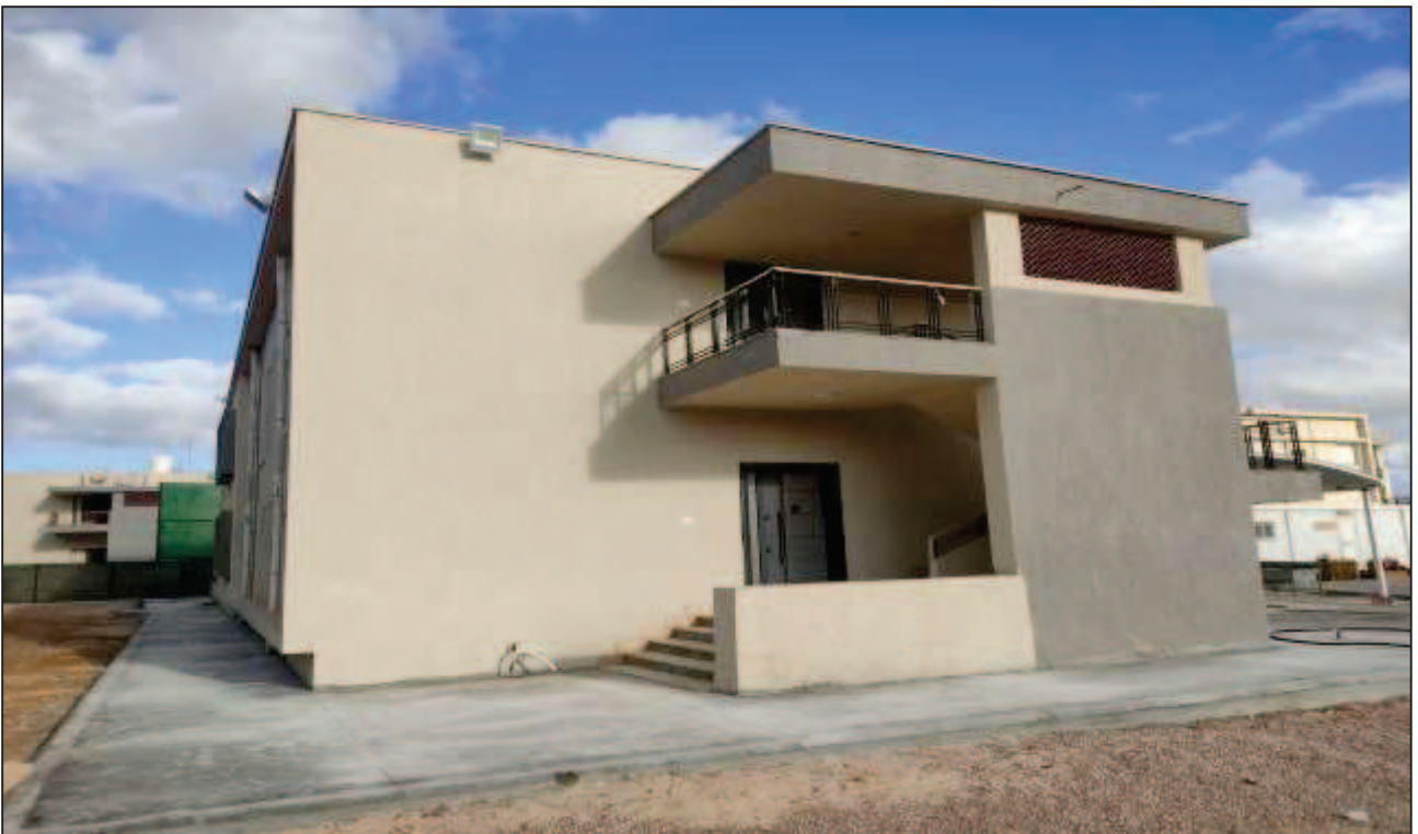
Immagine 4 – Vano scala esterno
