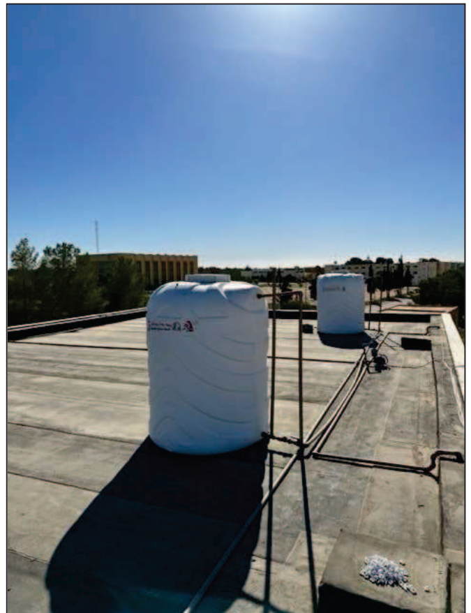
Figura 17 – Copertura lato corto
