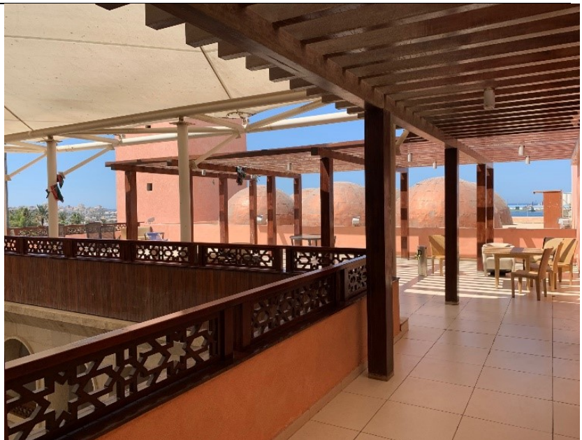
Terrazzo sito al terzo piano (lato NORD-OVEST)
