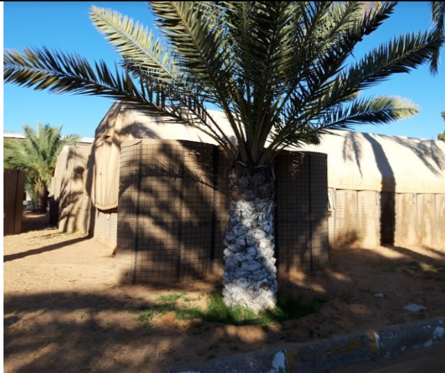
Bunker anti-mortaio (vista esterna)
