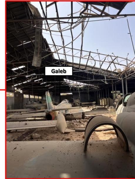
Il deterioramento subito dalle strutture portanti metalliche e di copertura degli H1 e H2 è irreversibile in quanto i missili che hanno impattato sulle due infrastrutture hanno dilaniato tutti gli ordini principali delle strutture metalliche rendendole completamente inagibili e non riparabili.
